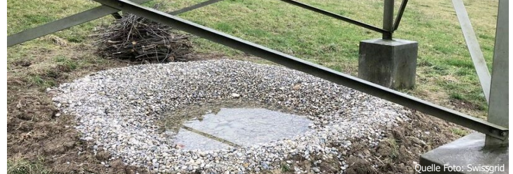
Freileitungsmasten mit einer Kombination verschiedener Kleinstrukturen.
