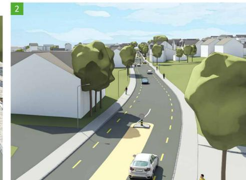
**C** Mit einem Mehrweckstreifen im Dorfzentrum wird der Verkehr durch eine optische Trennung beruhigt. Der Mittelteil schafft Platz für verschiedene Nutzungen. Er erleichtert das Linksabbiegen und ermöglicht das Vorbeifahren an stehenden Fahrzeugen. Die Strassen im ganzen Zentrumsbereich werden mit lärmindernden Asphaltbelägen ausgestattet.
