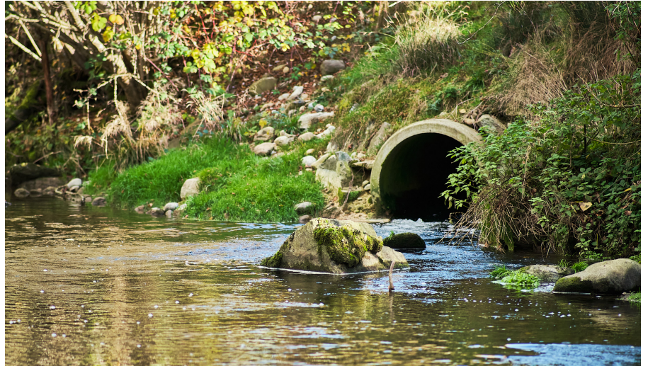
Einleitung der ARA Oberglatt in die Glatt.
