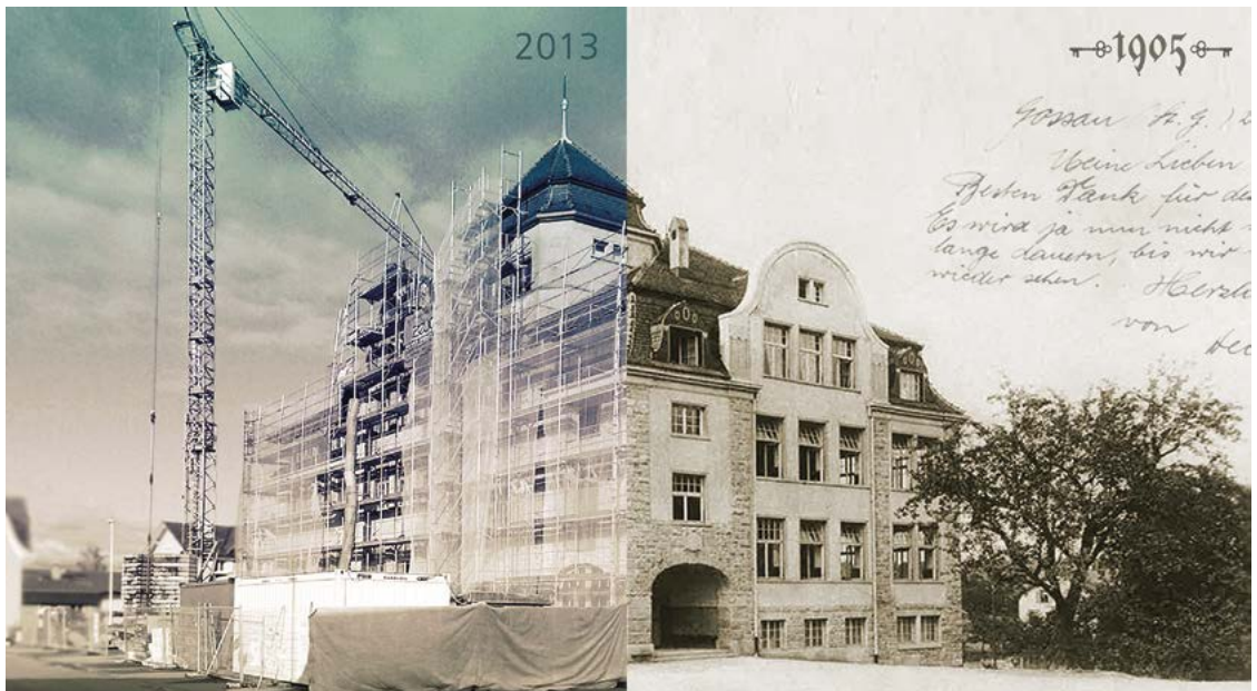
Das Schulhaus Haldenbüel, 1905 erstellt, wird bis Sommer 2014 saniert
