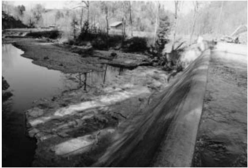
Das Kleinkraftwerk Niederglatt versorgt 125 Haushaltungen mit Strom.
