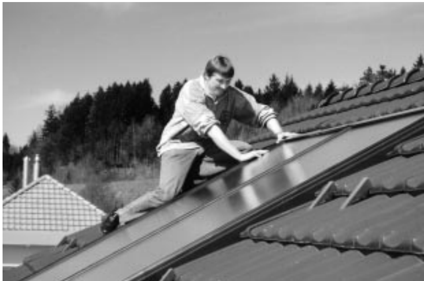
Mit Solarkollektoren erzeugt Christian Fatzer auf dem Dach seines Einfamilienhauses Warmwasser und Heizenergie.
